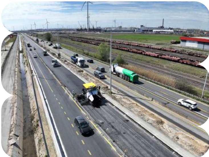
Knooppunt F.N. Piratenstraat - Asfaltering R4
