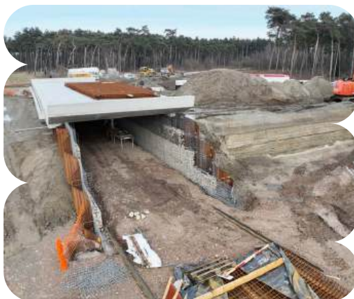
Knooppunt Wachtebeke: fietstunnel
