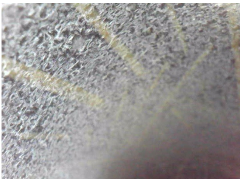
Przykładowe zdjęcie linera z widocznymi zmianami
