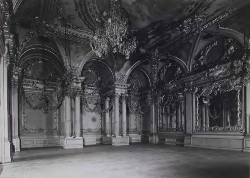
Jim PURCELL (1940 - 2013) Hôtel, salle des fêtes, vue d'ensemble, avant restauration, entre 1980 et 1987. Épreuve argentique 21 x 27 cm. Œuvre présentée exclusivement en région Bretagne
