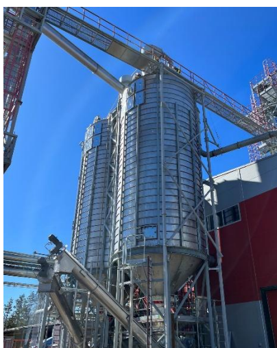
Rostfria silos, 2st, 240m 3 inkl sprängbleck skruvar etc.
