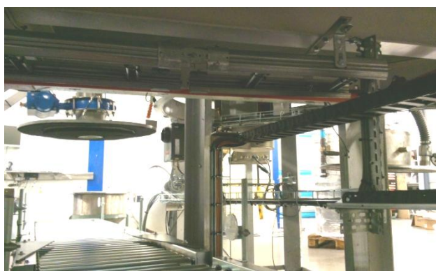
Fatfyllningsstationen sedd underifrån.
