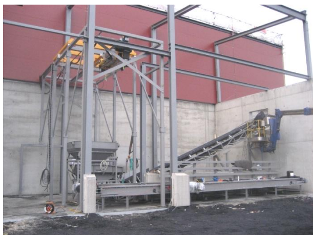
Anläggning håller på att färdigställas.
