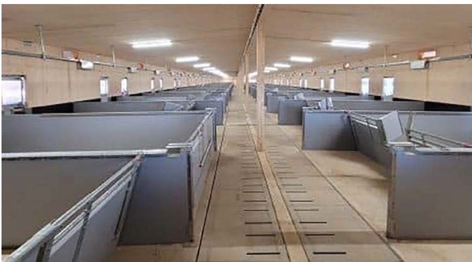
Gekühlte Zuluft strömt über einen Unterflurkanal in den Liegebereich.
