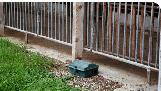
Une lutte systématique contre les rongeurs permet d'éviter les dommages qu'ils peuvent causer aux composants électriques. (Photo : SPAA)
