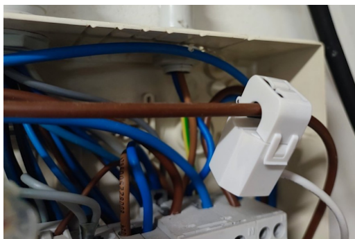
(a) Pinza amperometrica su quadro elettrico
