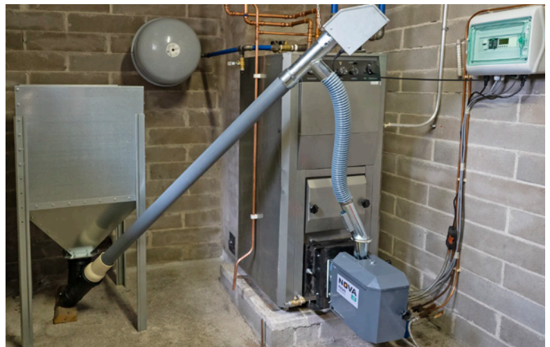
Esimerkkiasennus vanhaan öljykattilaan.
