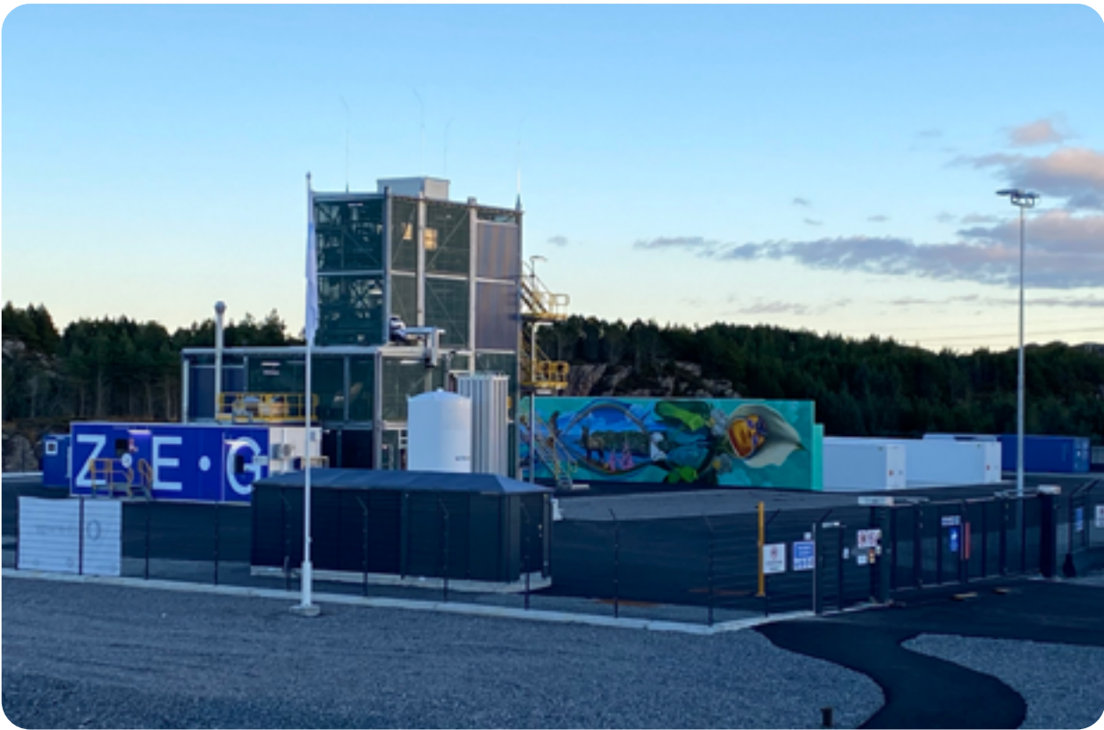
Pilotanlegg for produksjon av blått hydrogen fra naturgass, med CO 2 -fangst og -lagring i Energiparken på Kollsnes.
