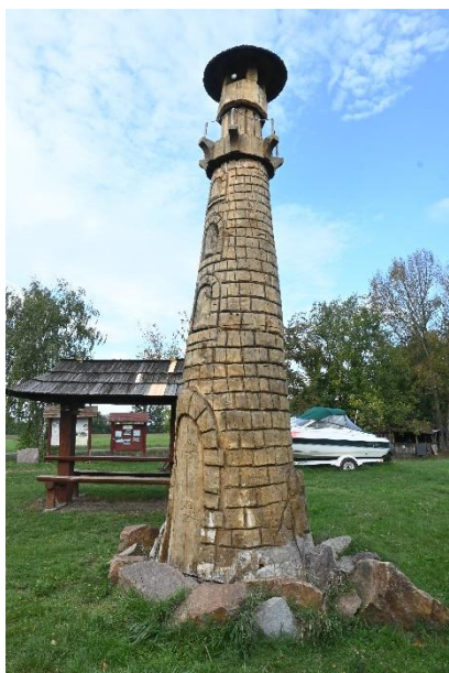
Obr. G1: Celkový pohled na maják od jihu
