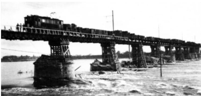
Palées du pont de Vierzon (Loiret) 19 novembre 1944, essai avec 5 locomotives
