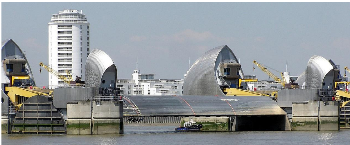
Figuur 4-17: Kering met segmentdeuren met horizontale as, op de Theems. 1 segmentdeur bevindt zicht in de onderhoudspositie (volledig naar boven gedraaid) tussen 2 pijlers. Grootste doorvaartopening = 200 ft (61 m). Bron: Wikipedia
