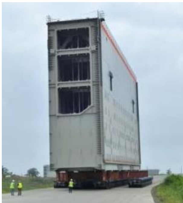
Figuur 4-7: Transport van een nieuwe roldeur voor het Panama-kanaal. De luchtkist bevindt zich onderaan. Er is een waterkerende plaat aan weerszijden van de structuur (links en rechts op de foto)
