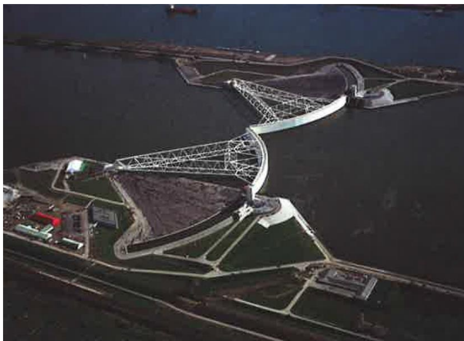
Figuur 4-11: Maeslantkering Rotterdam
