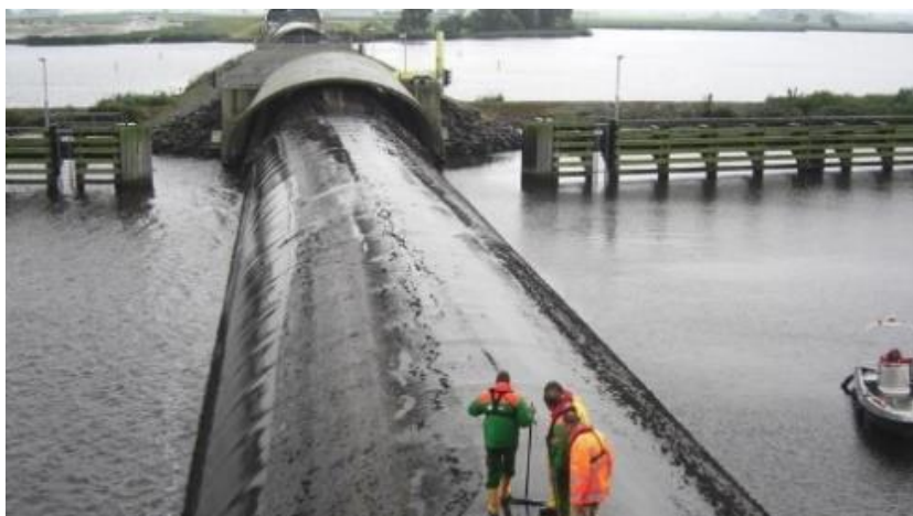
Figuur 2-4: Illustratie van een balgstuw in Ramspol, Nederland
