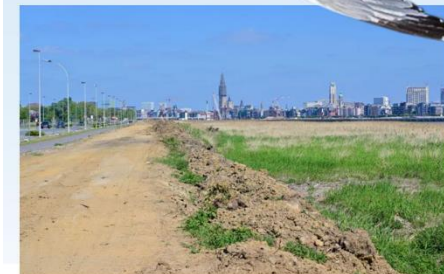
De dijkophoging beschermt Linkeroever tegen stormen.
