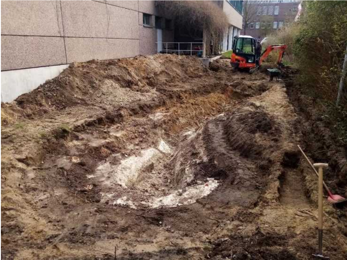
Aushub der Teichgrube (8.4.2021)
