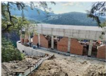
Цегляна кладка зовнішніх стін
