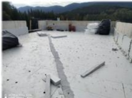
Влаштування покрівлі на даху
