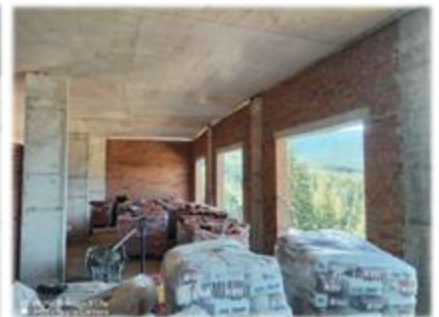
Цегляна кладка стінок перегородок
