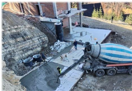
Влаштування бетонної підлоги під котельню
