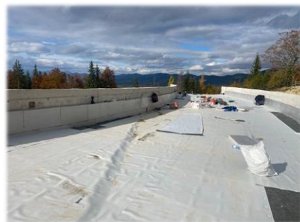
Влаштування теплоізоляційного шару по будівлі
