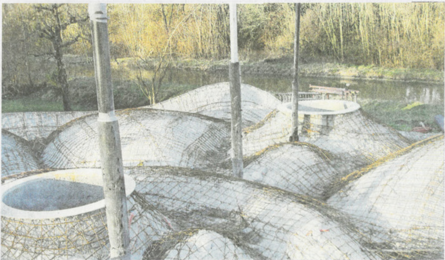
Die Erdhaussiedlung (oben) ist um einen Teich angeordnet. Im Innern herrschen fließende Linien, runde Formen und geschwungene Wände (Mitte). Das Gewölbe wurde mit Spritzbeton ausgekleidet (unten links). Über Lukarnen gelangt das Tageslicht in alle Räume. Fotos: Balz Murer (3), PD
