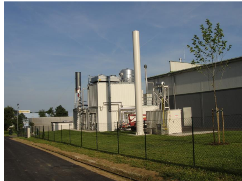
Biogasanlage Gülle/Mais Biogasaufbereitung Engerwitzdorf A 250 Nm 3 /h Biogas Baujahr 2011
