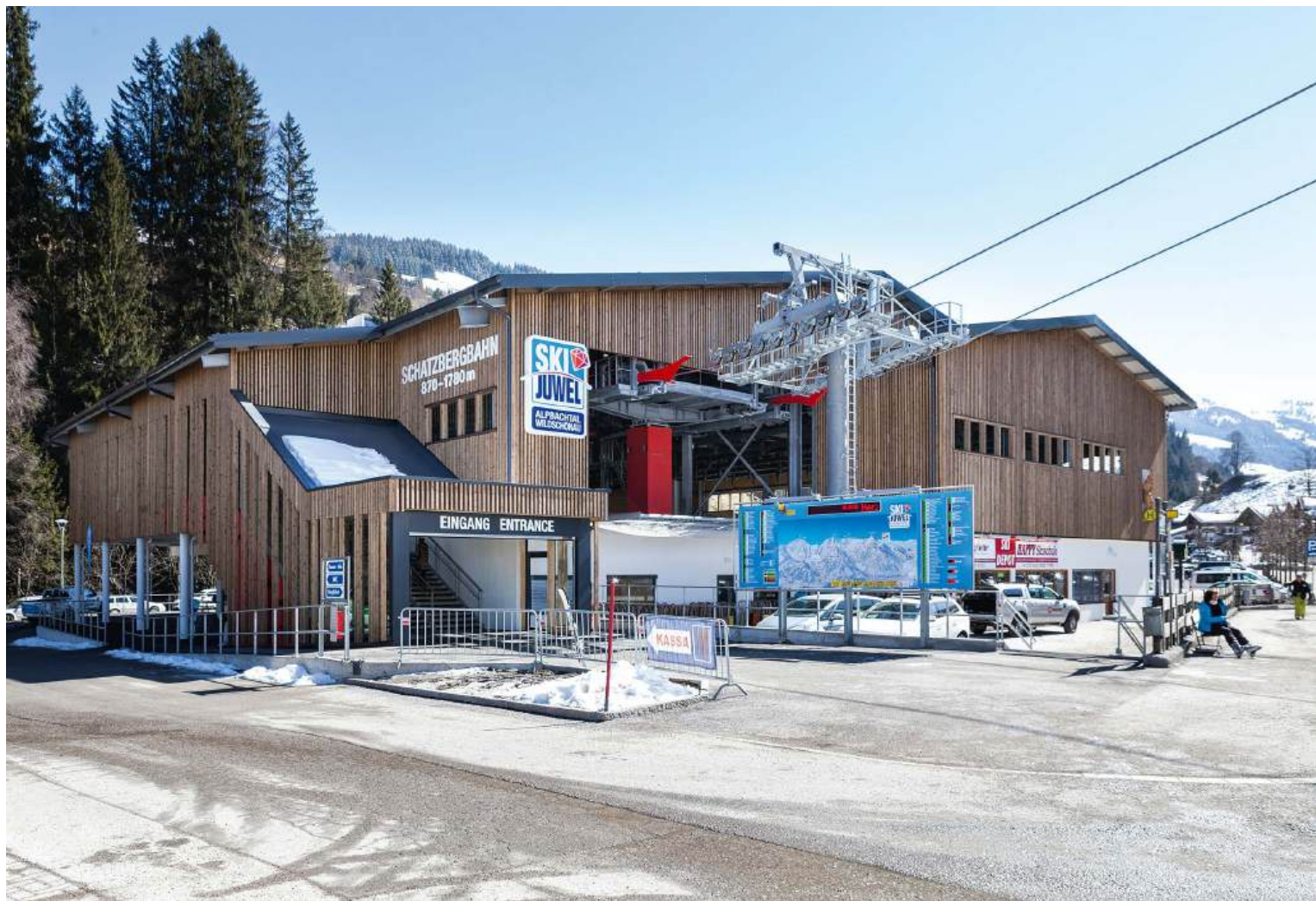
Bei der Talstation überspannt ein Stahlbau Teile des Untergeschoßes, die erhalten bleiben mussten, um die Infrastruktur weiter zu nützen. Auch an schönen Skitagen gibt es kaum mehr Wartezeiten. Bei der alten Anlage mussten sich die Skifahrer bis zu 50 Minuten anstellen.
