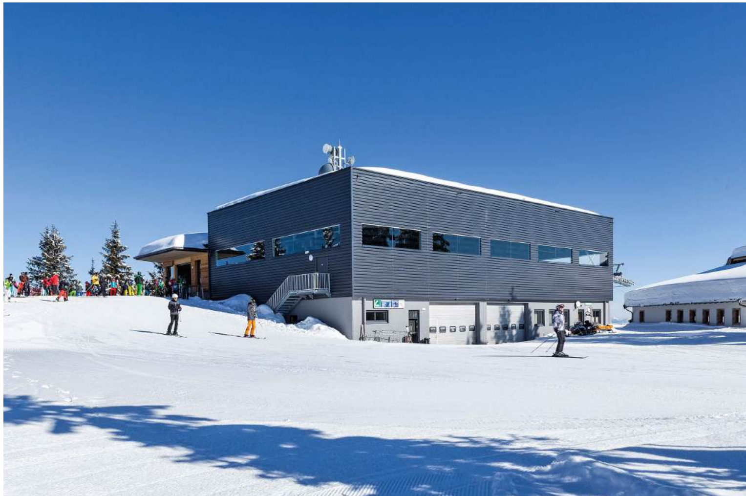
Um den engen Kostenrahmen einzuhalten, wurden die neuen Stationsgebäude auf die bestehenden Untergeschosse gebaut.
