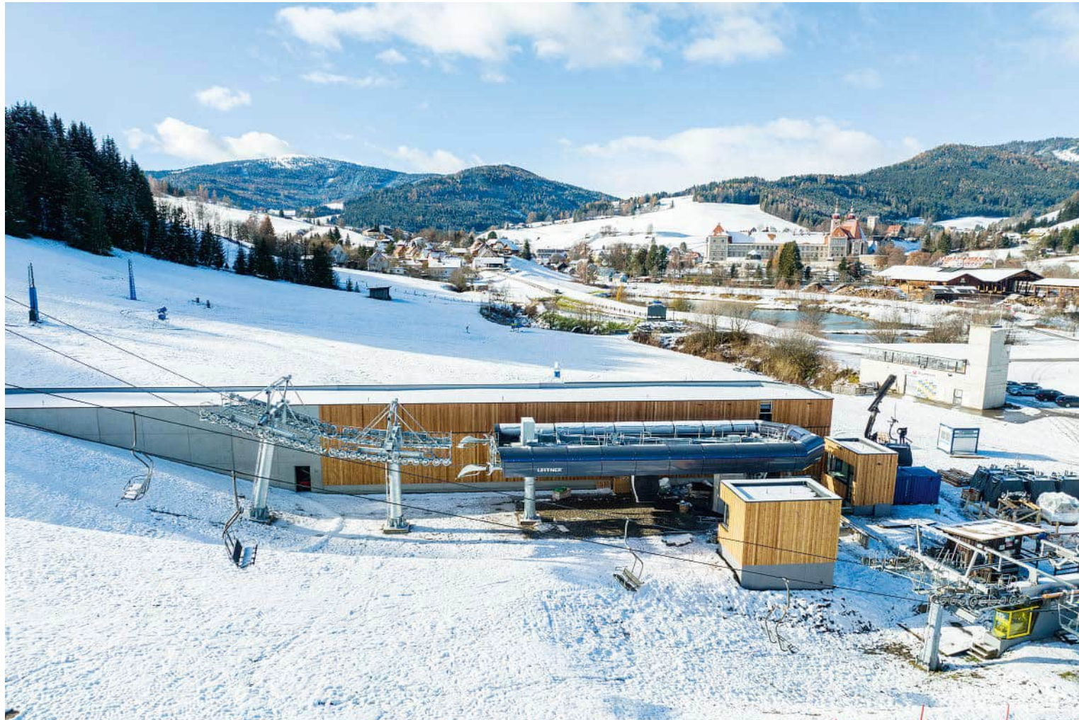
Seit Weihnachten 2022 befördert die in Rekordzeit errichtete 10-Kabinen-Einseilumlaufbahn „Greben10“ die Wintergäste ins Skigebiet.
