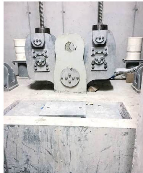
Die Abspannung des Förderseils ist in der Talstation untergebracht und mechanisch mit einem Betongewicht ausgeführt.
