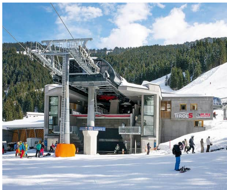
Die Abspannung des Förderseils ist in der Talstation untergebracht und mechanisch mit einem Betongewicht ausgeführt.
