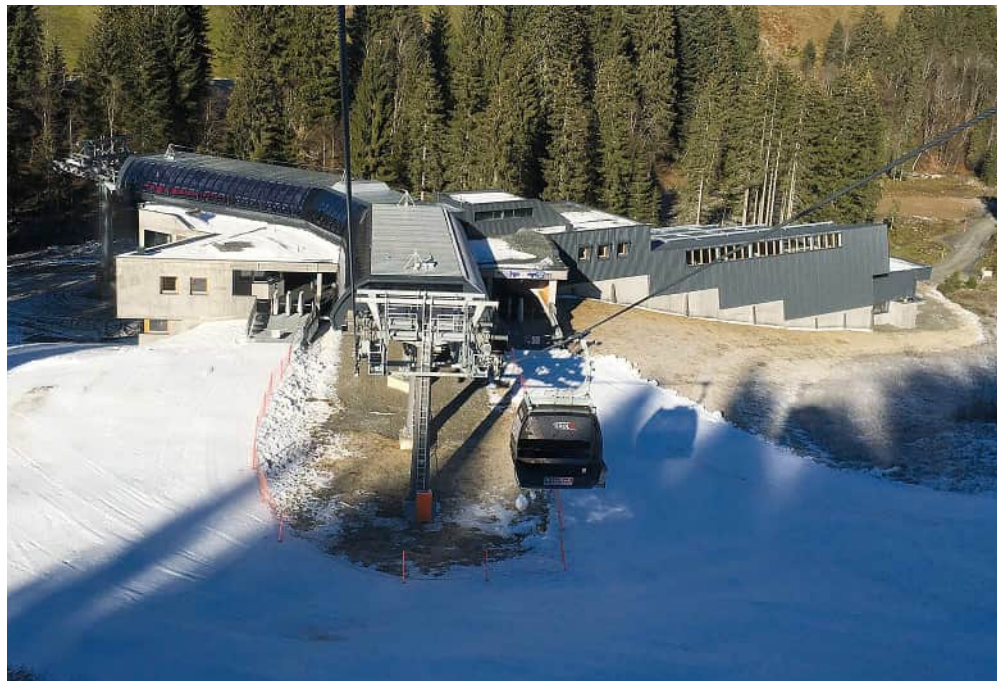
Die Abspannung des Förderseils ist in der Talstation untergebracht und mechanisch mit einem Betongewicht ausgeführt.
