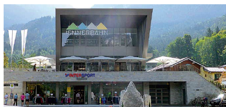
Die neue Talstation bietet viel Platz für Büro, Skidepot, Kassa und Shop.
