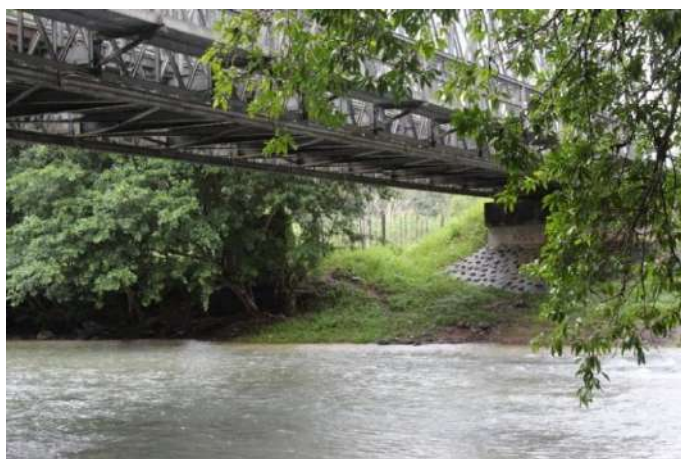
Ilustración 5-26 Puente modular sobre el río Teriá
