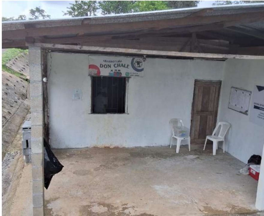
Ilustración 5-44 Estructuras de uso comercial en El Congo, área de actividades conexas
