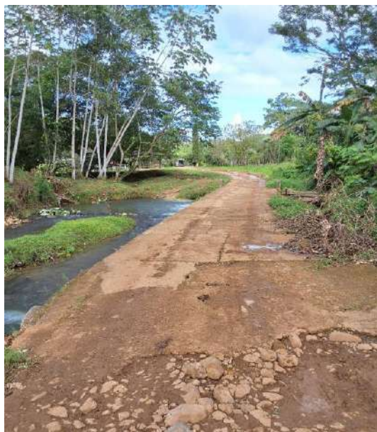
Puente vehicular una vía, concreto
