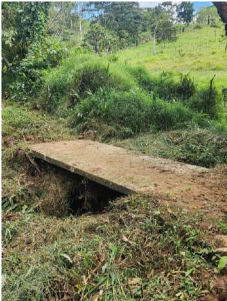
Puente peatonal de concreto
