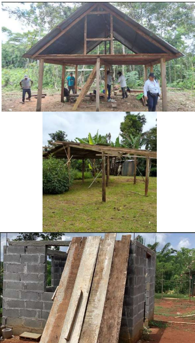
Ilustración 5-46 Estructuras privadas en construcción en el área de proyecto
