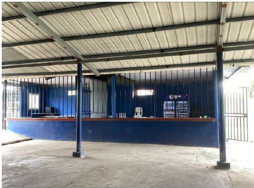
Ilustración 5-45 Estructura de uso comercial en Circito, área de actividades conexas
