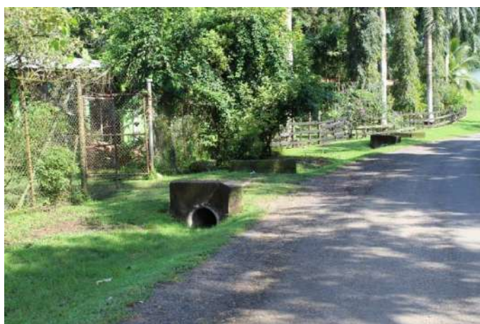
Ilustración 5-25 Carretera de asfalto en Tres Hermanas
