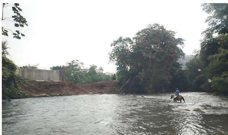
Ilustración 5-20 Construcción de puente sobre el río Indio
