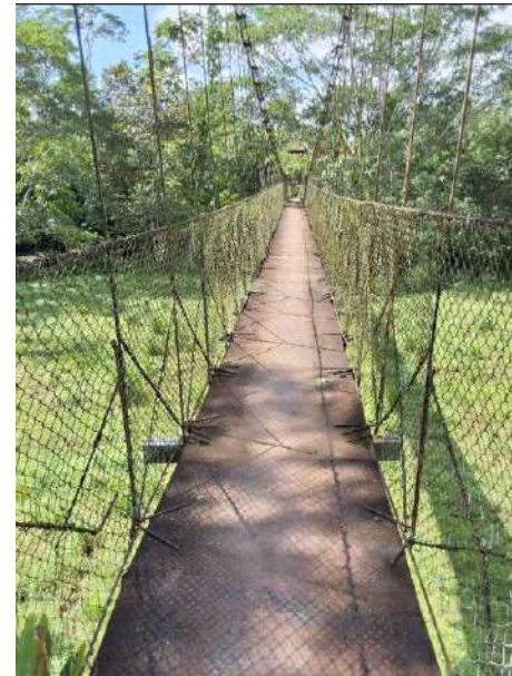
Puente peatonal complejo
