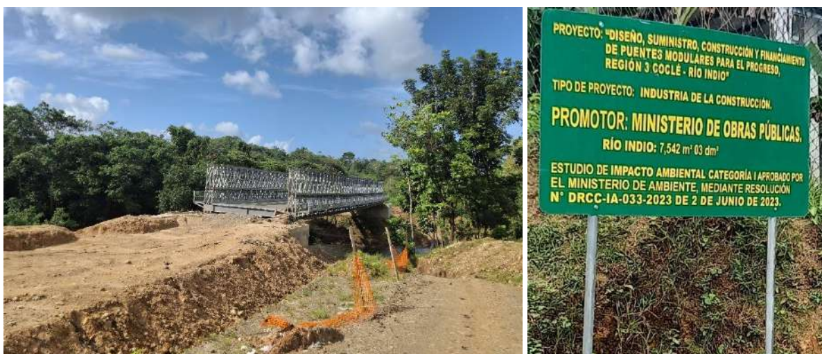
Ilustración 5-1 Construcción del puente modular sobre el río Indio
