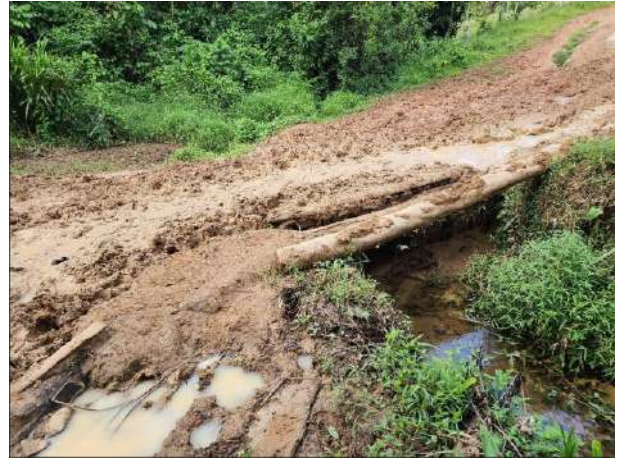
Puente vehicular una vía
