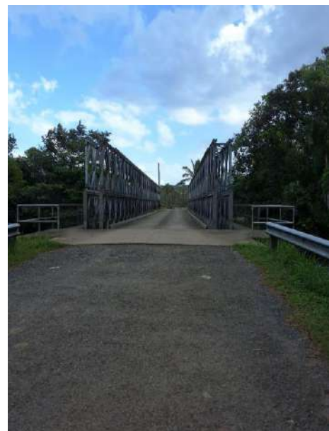
Puente vehicular una vía, acero
