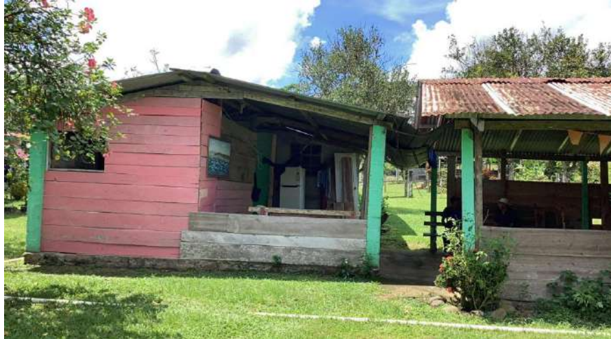
Ilustración 5-40 Estructura principal de la vivienda (variedad de estructuras identificadas)
