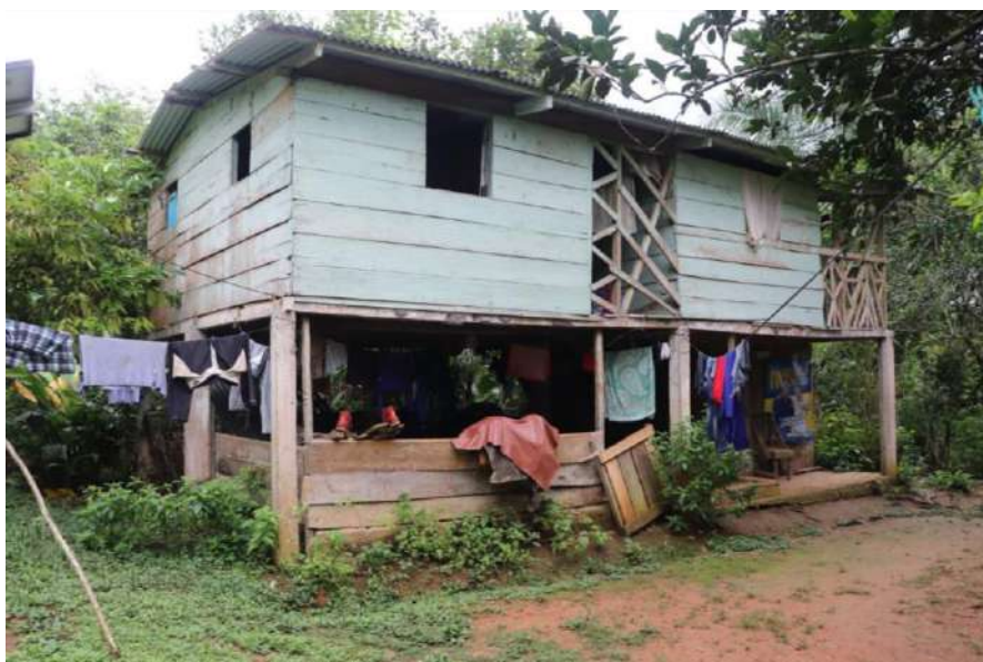
Ilustración 5-49 Vivienda de 2 pisos
