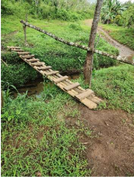
Puente peatonal improvisado
