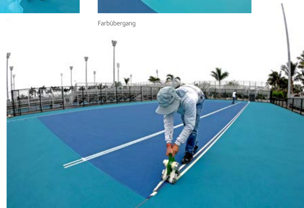
Auftragen des LM Topcoat
