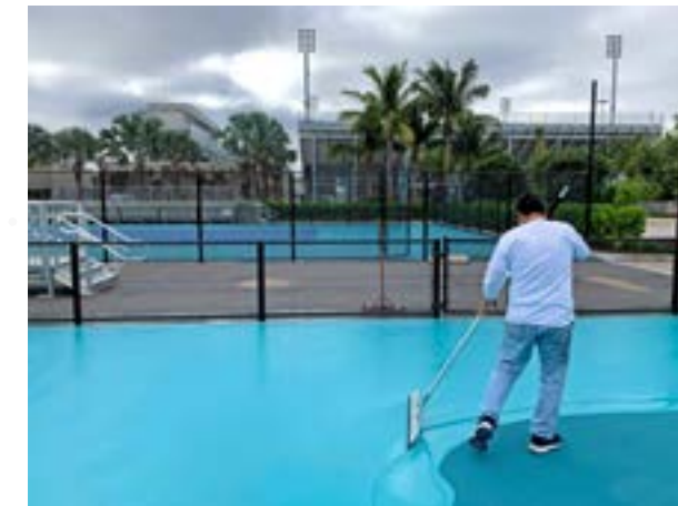
Auftragen des LM Topcoat
