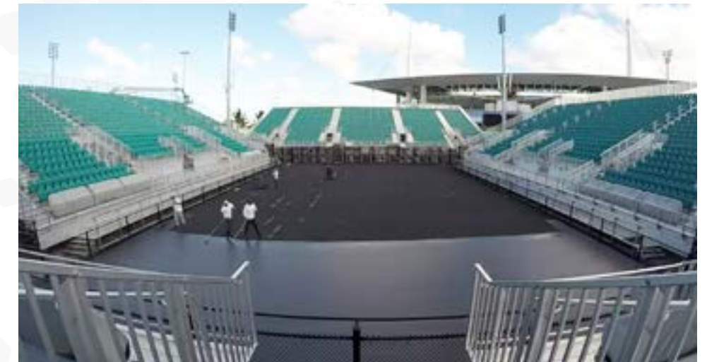
Auftragen des Laykold Resurfacer
