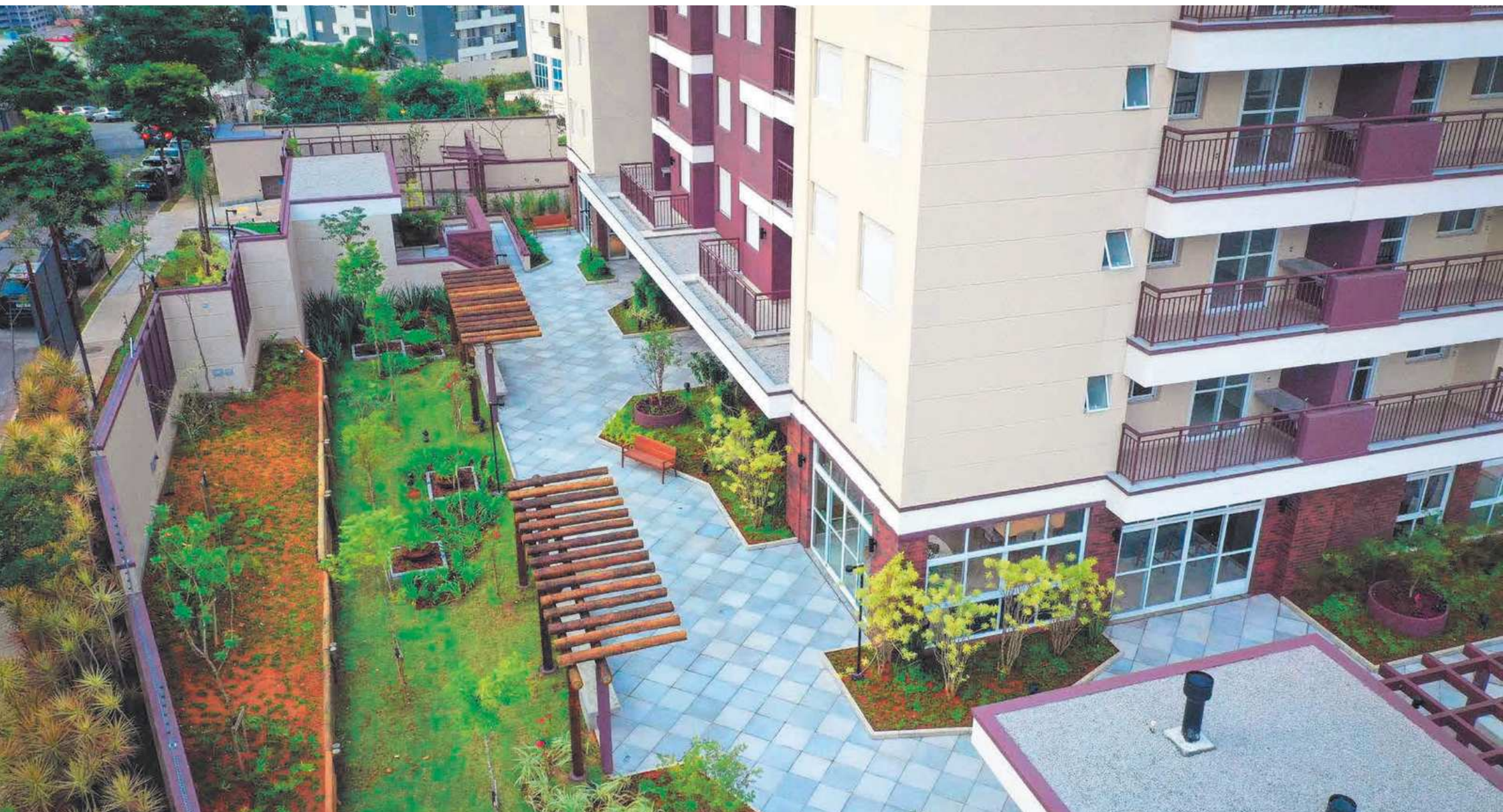
Foto do Pavimento Térreo
