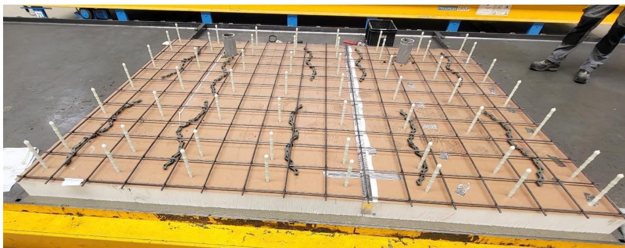
Rys. 6 (Fot. 2) Widok warstwy elewacyjnej po zabetonowaniu ułożeniu izolacji i osadzeniu akcesoriów
