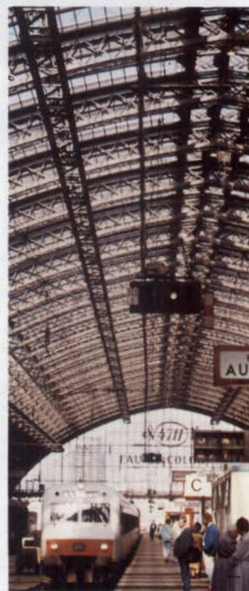
Abb. 7: Blick in die historische Halle.
