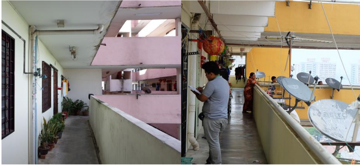
Foto 2.3: Pandangan dekat—Membandingkan reka bentuk blok
