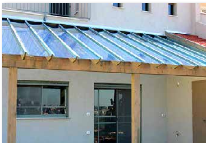
Instalación sobre vigas - Bajos costes de instalación y estructura Pendiente mínima 5%
