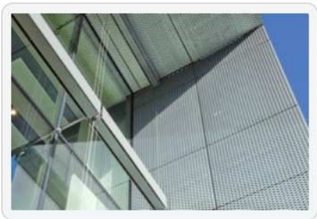
Oeconomicum der Universität Düsseldorf mit feuerverzinkter Streckmetallfassade
