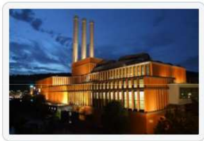
Heizkraftwerk Würzburg mit feuerverzinkter Fassaden- Unterkonstruktion
