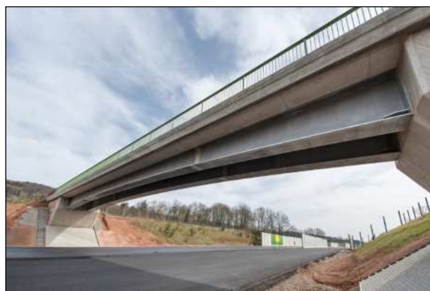
Bild 45: Gesamtansicht der fertiggestellten Brücke (DEGES/ Frank Zerbst)
