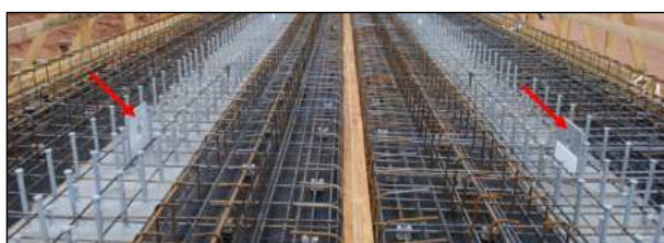
Bild 19: Auf dem Obergurt der feuerverzinkten Bauteile verbliebene Anschlagpunkte (IFG)
