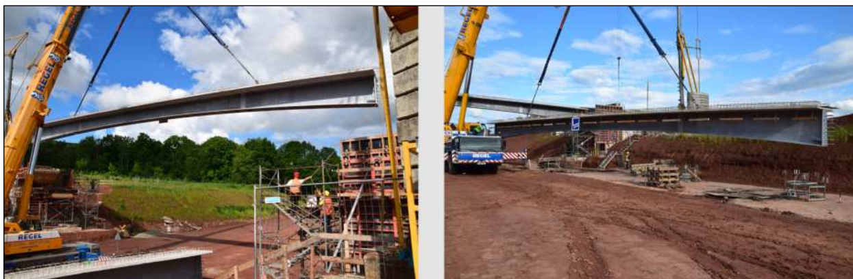
Bilder 15.1 und 15.2: Einheben der Brücke (DEGES)
