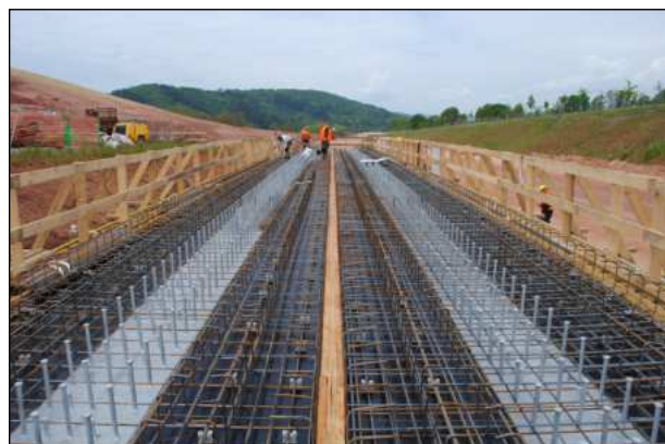
Bild 14: Vorbereitung der Schalung für das Halbfertigteil (IFG)
