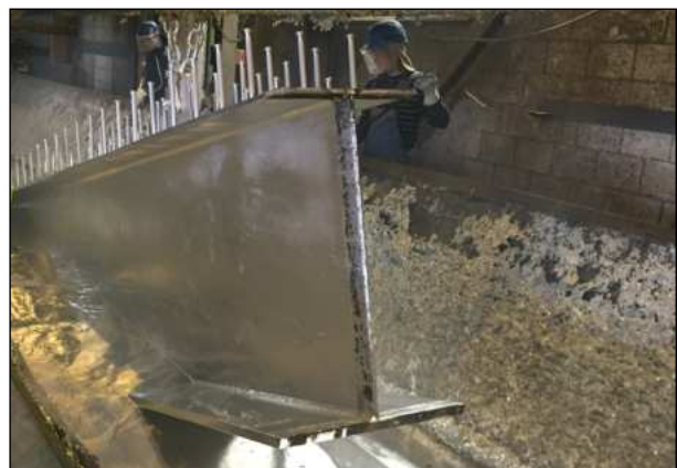
Bild 32: Äußeres Brückensegment während des Feuerverzinkungsprozesses (IFG)
