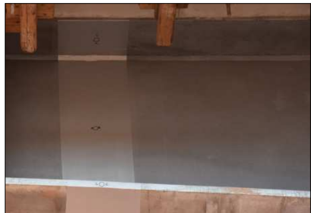
Bild 42: Thermisch gespritzter Baustellen-schweißstoß (Achse A) mit markierten Punkten für die Langzeitmessung (IFG)
