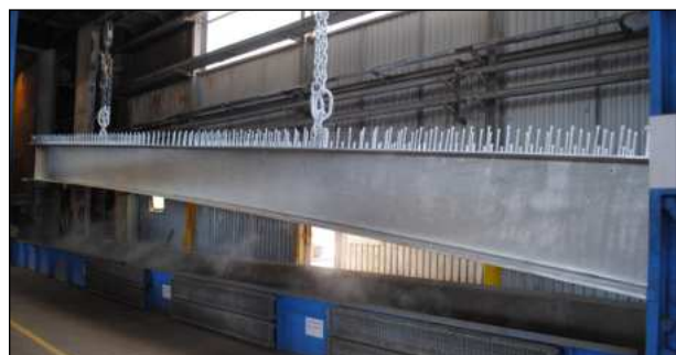
Bild 34: Mittleres Brückensegment nach dem Feuerverzinkungsprozess (IFG)
