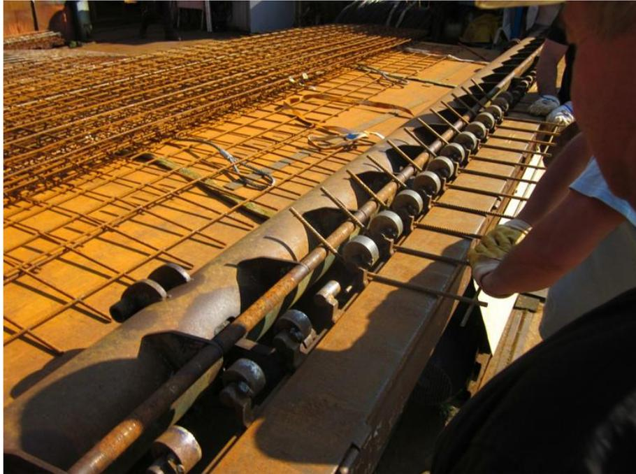
**Bild 83: Biegen der Mattenstücke (Mattenkörbe),  $d_{Br} = 80 \text{ mm}$ ,  $a = 40 \text{ mm}$**
