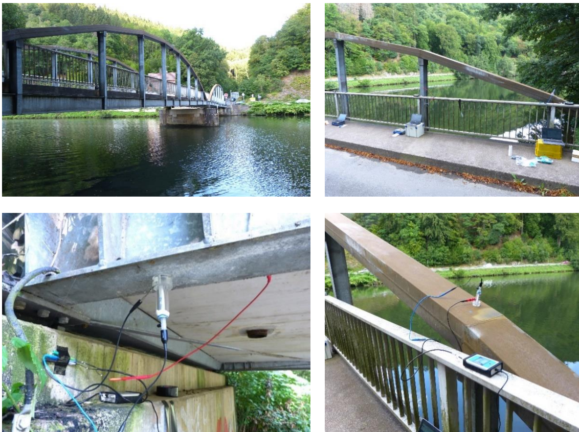
Abbildung 7: Eindrücke von der Feldmesskampagne an der Höllmeckebrücke bei Werdohl a) links oben – Übersichtsbild Höllmeckebrücke bei Werdohl, ländliche bis städtische Atmosphäre b) rechts oben – Eindruck der parallel verlaufenden Messungen der Messpartner c) links unten – angebrachte Messzelle an der Unterseite der Brücke d) rechts unten – angebrachte Messzelle an Trägern der Brücke, durchgewachsene Zink-Eisen-Legierungsschichten
