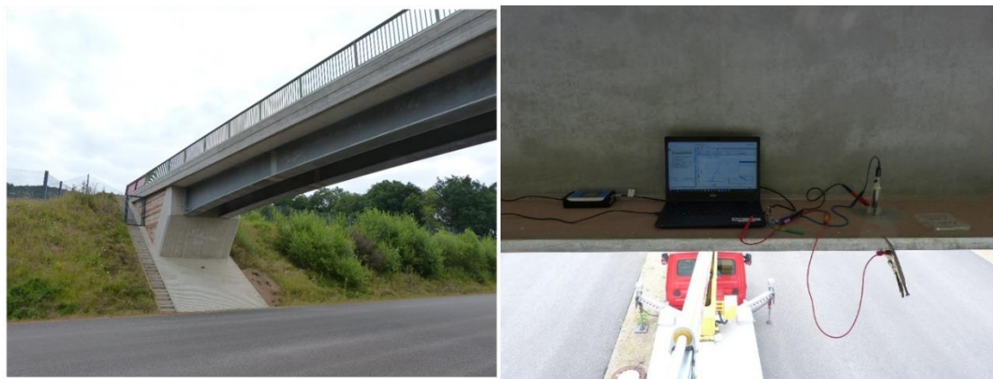
Abbildung 5: Messkampagne an einem feuerverzinkten Brückenträger über die A44 bei Waldkappel, links: Brücke mit feuerverzinktem Brückenträger, rechts: Feldmessgerät für die Bestimmung von Deckschichtwiderständen mittels Gelelektrolyt
