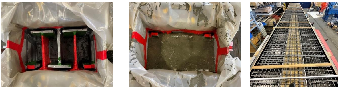
Abbildung 22: Vorbereitung / Verguss des Stoßbereiches und Bewehrungsarbeiten
