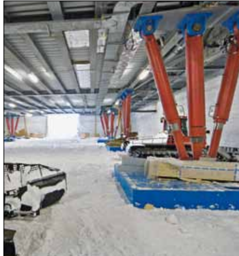
2 Hydraulik-Stützen der Neumayer III-Station
