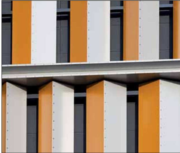
4 Aluminium-Fassade mit feuerverzinkter Tragkonstruktion
