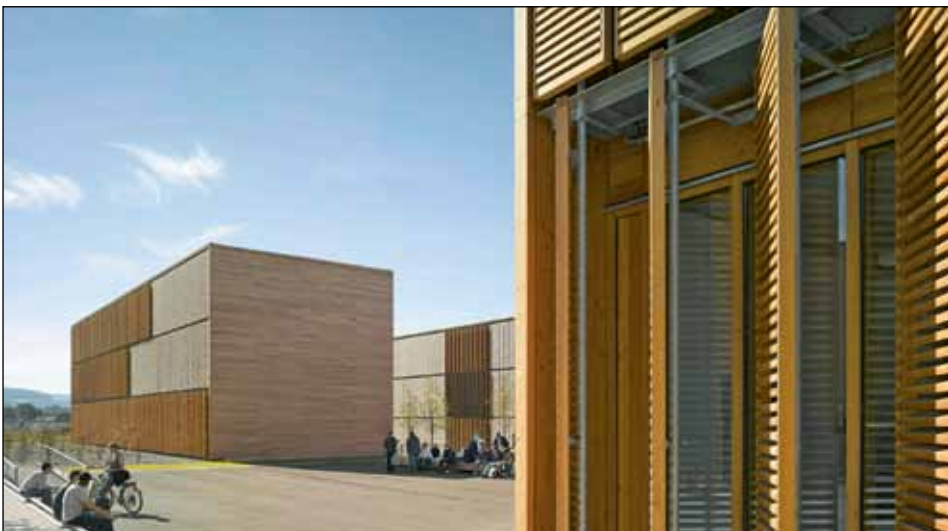
2 Steuerbare Lamellenfassade mit feuerverzinkter Unterkonstruktion
