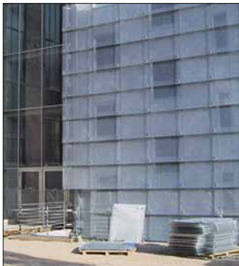
1 Feuerverzinkte Schuppenfassade aus Streckmetall
