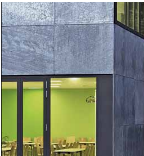
2 S. 4: Kubus mit feuerverzinkter Stahlfassade
