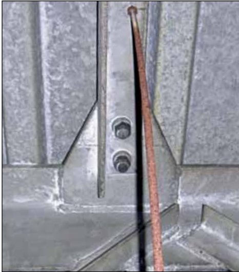
3 Top: Verzinkte Bauteile nach 35 Jahren
