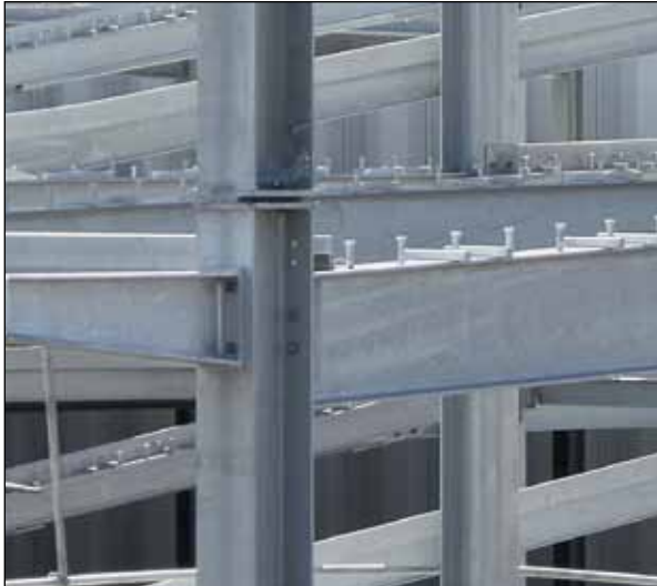
4 Feuerverzinktes Stahltragwerk eines Parkhauses
