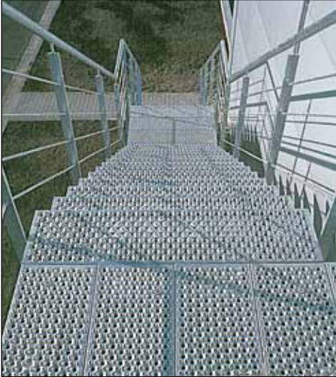
7 Treppe mit Stufen aus Blechprofilrosten
