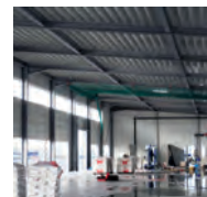
Abb. 1: Hallenkonstruktion mit R30-Brandschutz durch Feuerverzinken.
