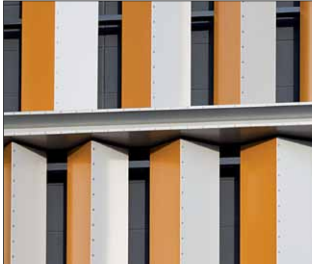
4 Aluminium-Fassade mit feuerverzinkter Tragkonstruktion
