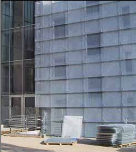
1 Feuerverzinkte Schuppenfassade aus Streckmetall
