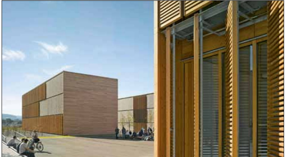
2 Fassade aus feuerverzinkten Blechen
