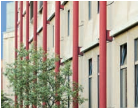
➔ Detailfotos einer Inspektion der Beschichtung nach 28 Jahren.
