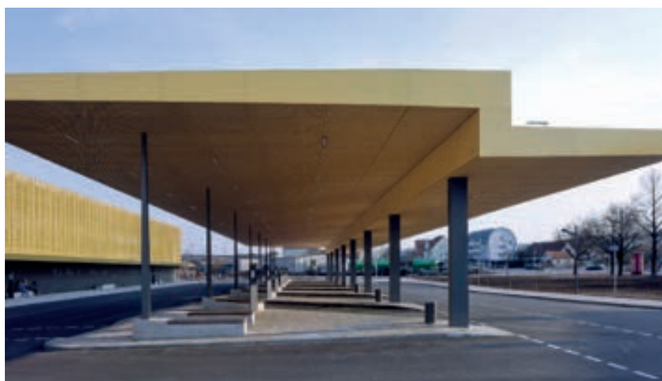
→ ÖPNV-Drehscheibe Nördlingen mit duplex-beschichteter Stahlkonstruktion (Architekten/Fotos: Morpho-Logic)
