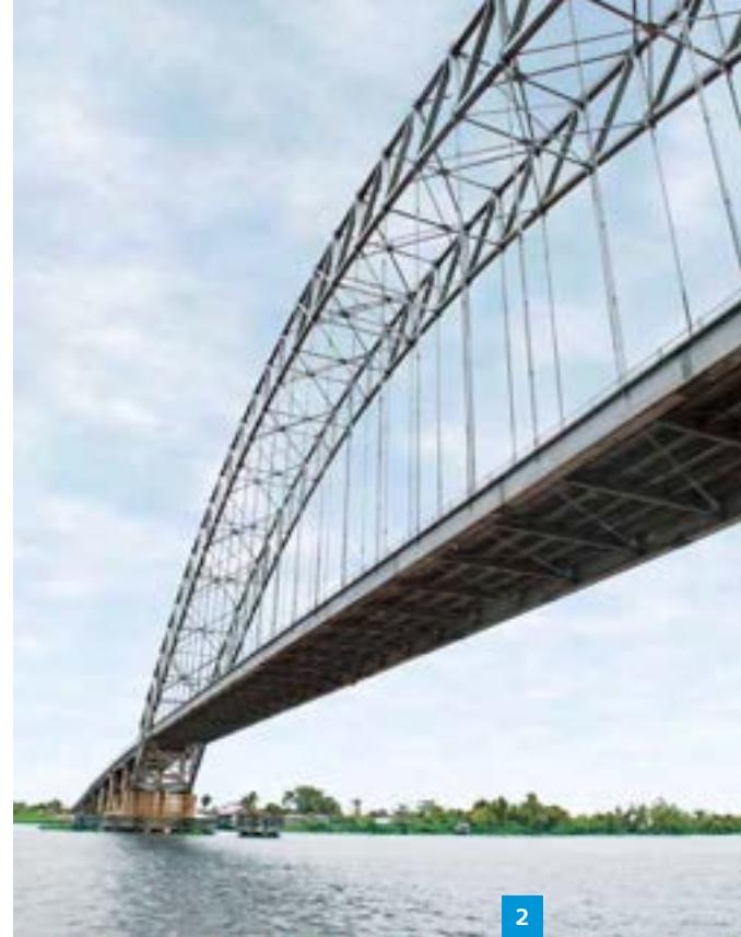
**1 | Die feuerverzinkte Bogenbrücke hat eine Spannweite von 200 Metern.**
