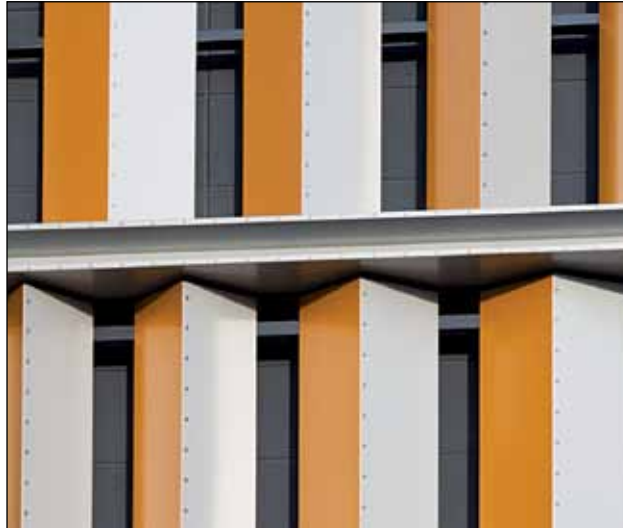
4 Aluminium-Fassade mit feuerverzinkter Tragkonstruktion
