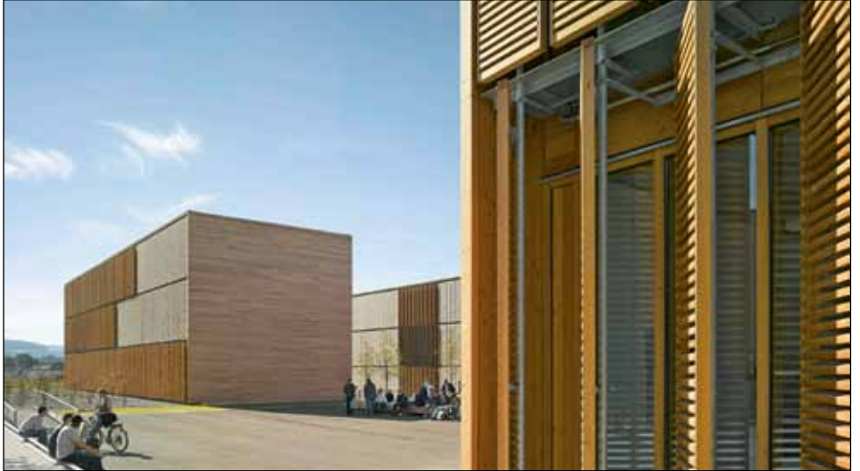
2 Fassade aus feuerverzinkten Blechen
