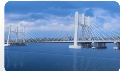
Rod El-Farag Bridge, Egypt
