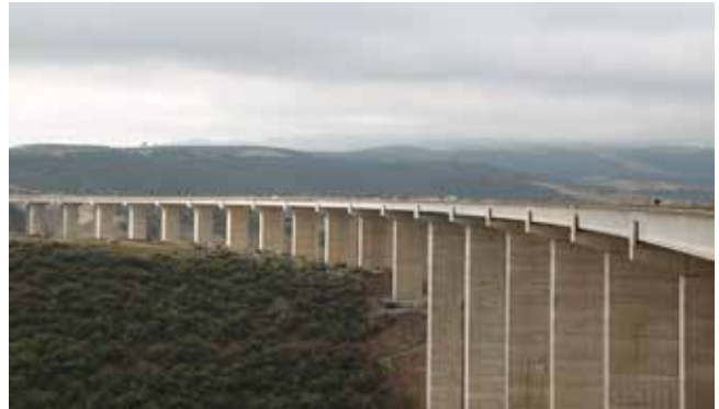
ALGERIA REALISATION DE LA SECTION AUTOROUTIERE ENTRE LA CHIFFA ET BERROUAGHIA SUR 53KM
