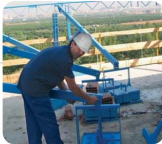
Ilustración 4. Montaje de pescante de contrapesos
