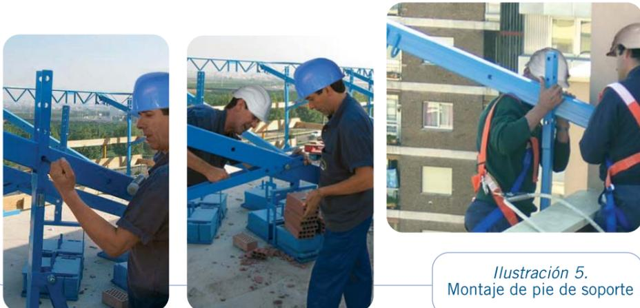
Ilustración 5. Montaje de pie de soporte
