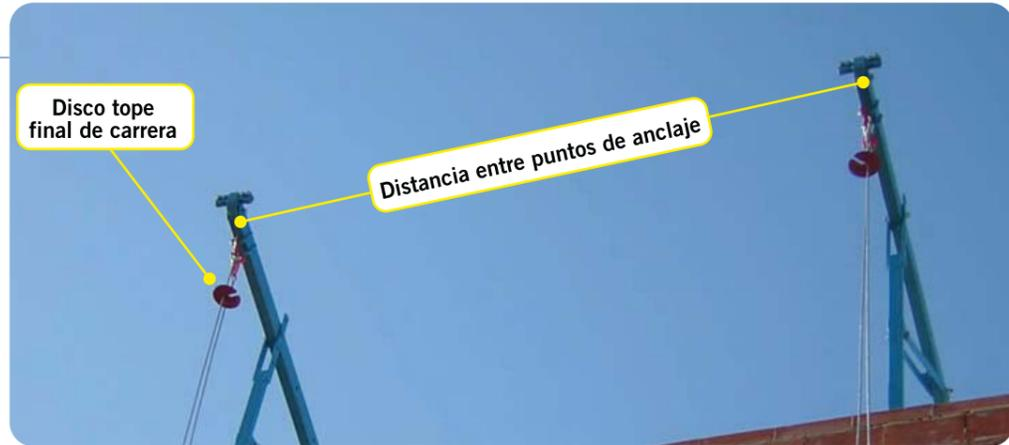
Ilustración 12. Conservar distancia entre puntos de anclaje
